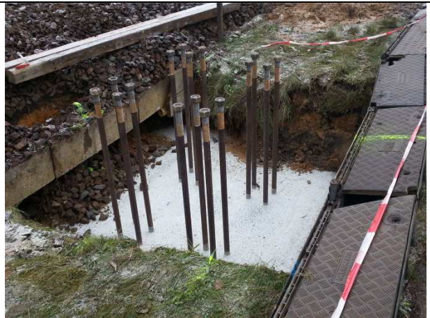
Betonieren des unteren Fundamentblocks
