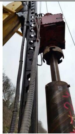
Eindreihen des Rohrs
