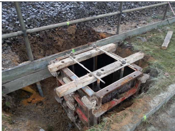
Schalung des oberen Fundamentkopfes
